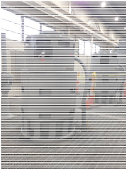
Effluent Pumps
